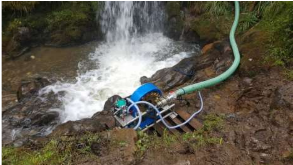
Figura 66. Puesta en funcionamiento de la turbobomba con turbina Pelton. Fuente: autores
