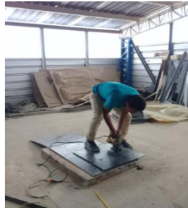
Figura 3.3 Corte de la lámina de polipropileno.
