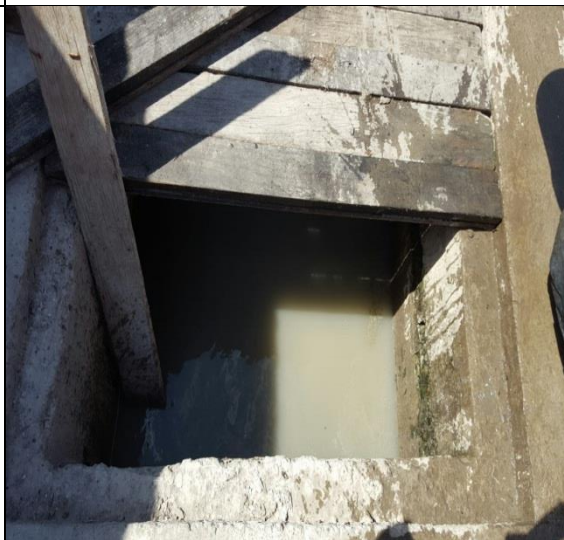
IMAGEN 6. Saturación de lodo en el Material Filtrante
