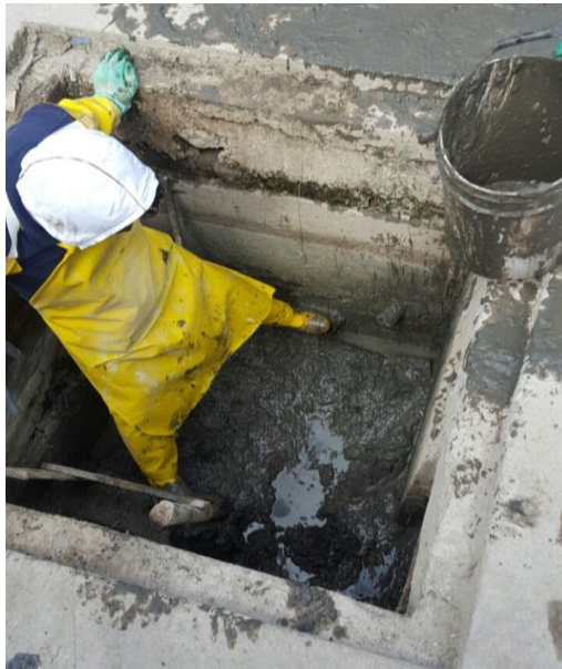
IMAGEN 11. Limpieza del Pozo de Recolección
