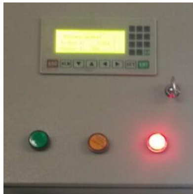
Figura 4.69: Encendido de luz roja indicando nivel bajo del tanque
