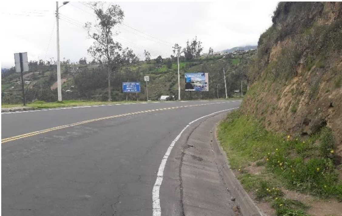
Figura 4.2: Inicio de la Vía Pelileo-Baños
