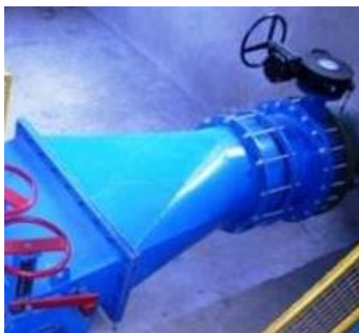
Figura 2.16 Inyector de la turbina tipo Michell Banki
