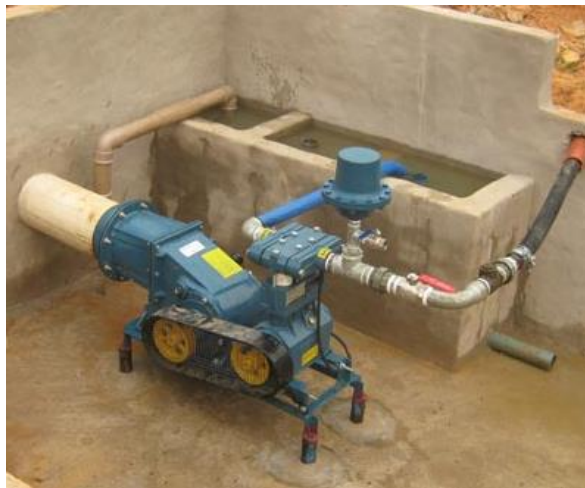
Figura 2.1 Turbo bomba
