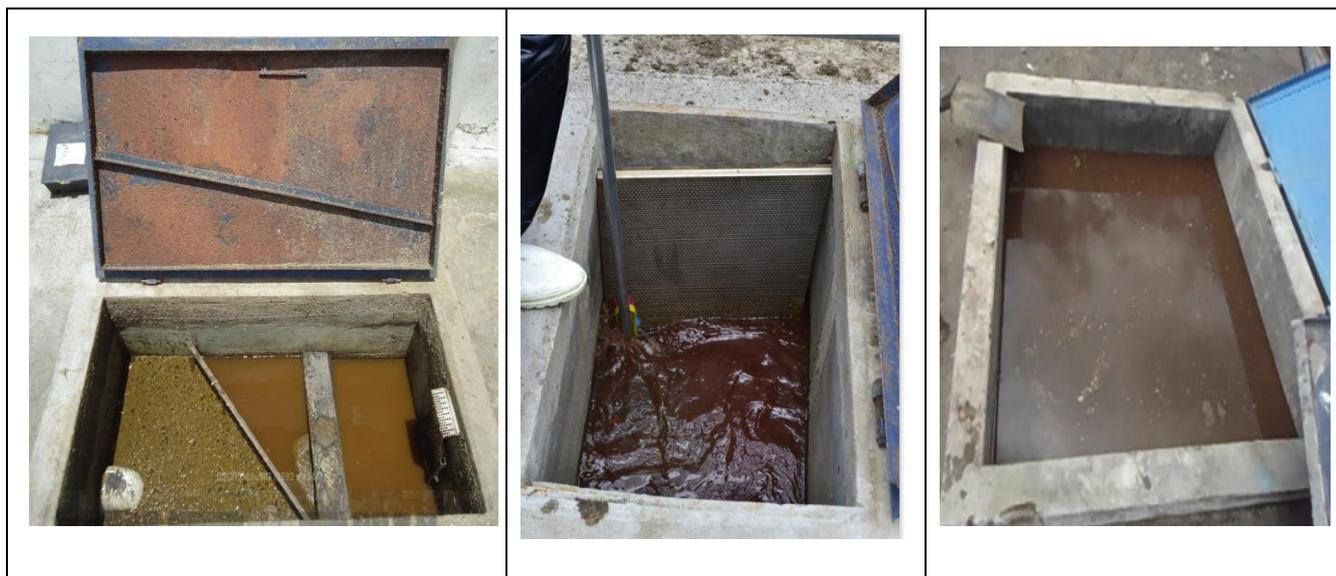
**Fig. 7.** Tanque de retención de sólidos gruesos.
