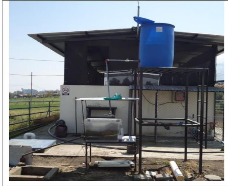
**Fig. 3.** Biofiltro instalado en el camal
