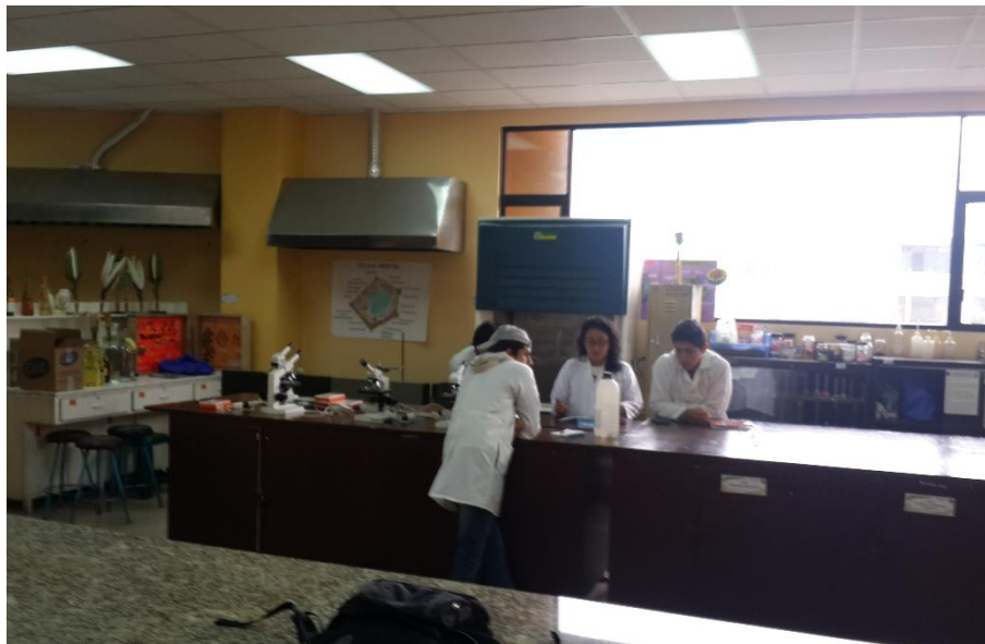
Figura 20. La ausencia de controles de iluminación natural, puede dar origen a deslumbramientos y reflejos molestos sobre las superficies de trabajo.
