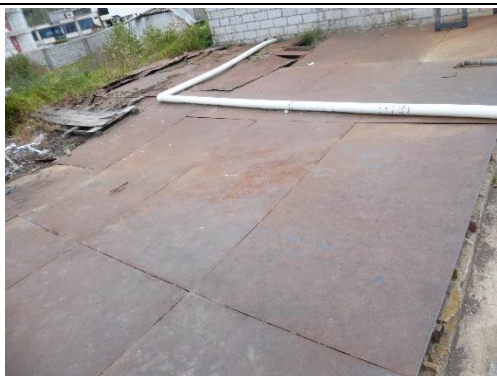
Tanque 1 (con tapa) de reserva de agua de regadío para el funcionamiento operativo de la Industria.
