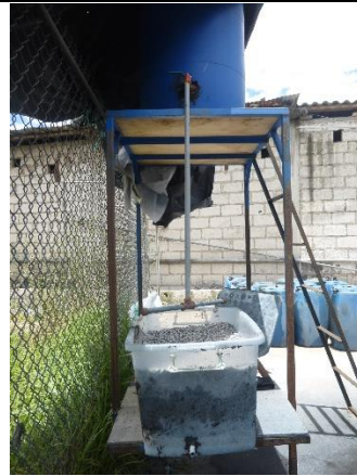
Filtro artesanal instalado sobre una estructura metálica de 1,70 m, listo para tartar el efluente de la Industria.
