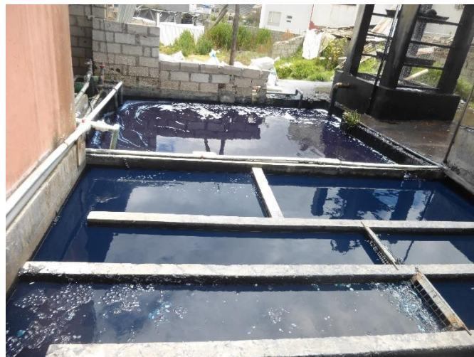
Ilustración 5. Planta de tratamiento de la Industria.
