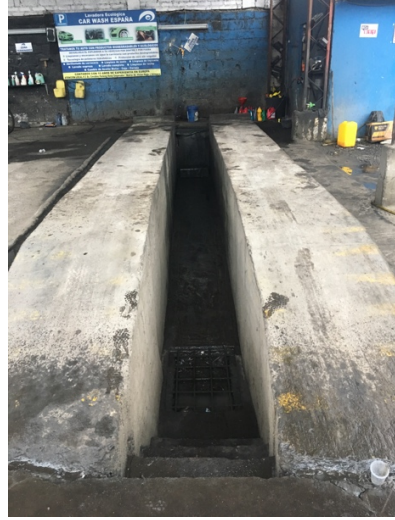
8. Rampa principal de la industria
