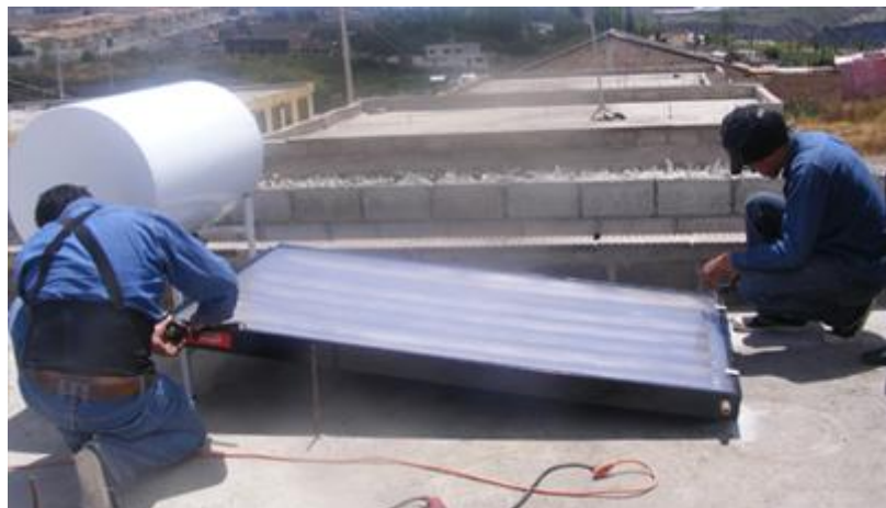
Figura 3. Instalación de calentadores solares en la Provincia del Carchi
