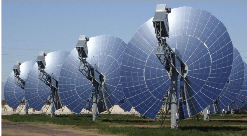
Figura 24. Concentrador solar de alta temperatura con discos parabólicos
