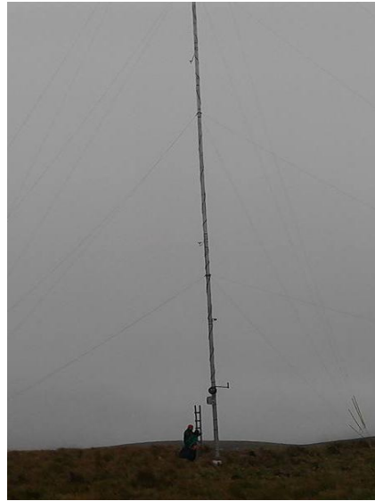
Figura 5. Torre de medición meteorológica
