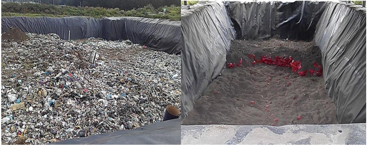
Figura 20. Relleno sanitario de la Mancomunidad GIDS Pujilí-Saquisilí; Celda emergente de desecho comunes (izquierda); Celda emergente de desechos hospitalarios (derecha).
