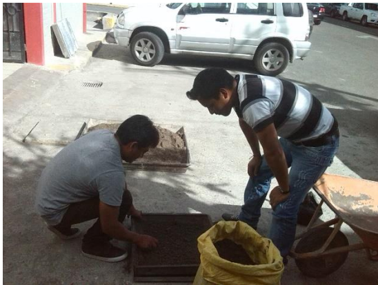
Ilustración 3. Arena Tamizado Separación de Grava.
