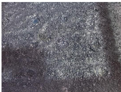
Ilustración 9. Estado del Material últimos días
