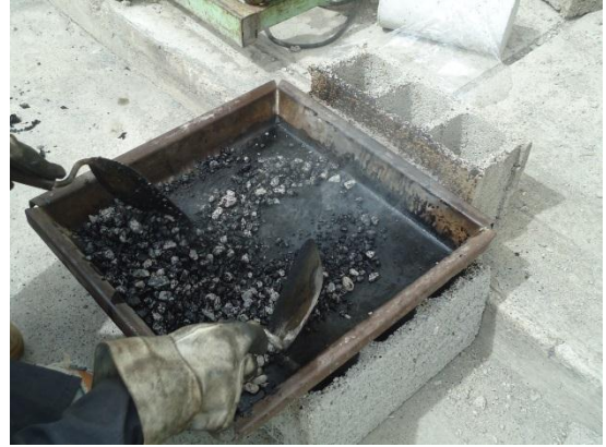
Mezclado de los agregados y asfalto
