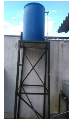
Imagen 6. Instalación del tanque de reserva
