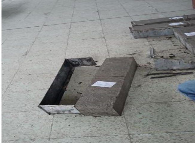
Anexo 16. Desencofrado de las vigas
