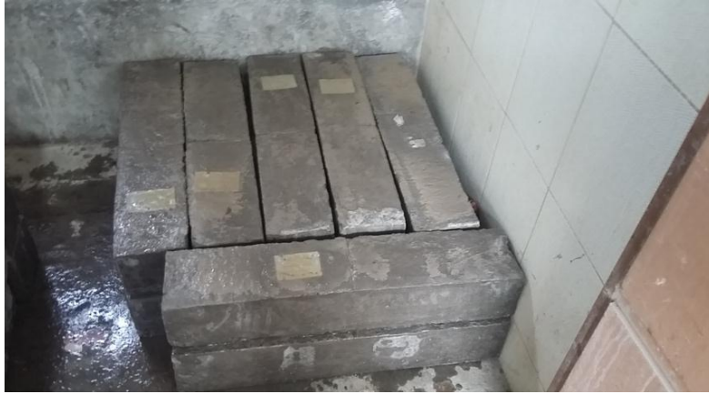
Anexo 19. Secado de vigas de hormigón armado
