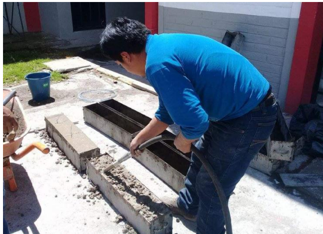
Anexo 15. Proceso de hormigonado de las vigas
