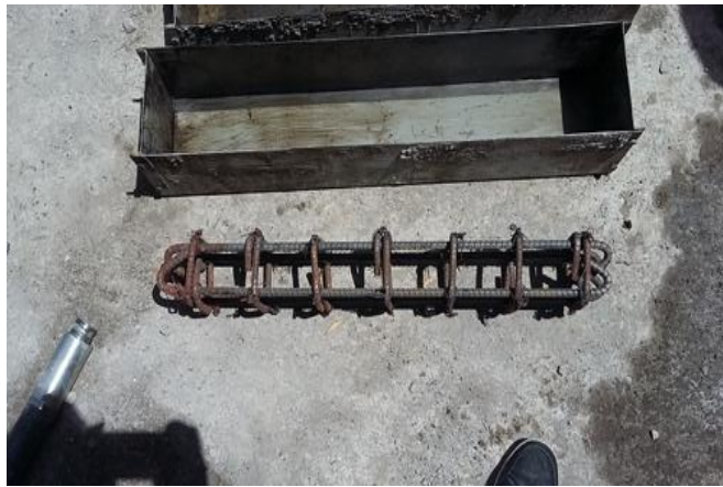
Anexo 14. Armado de las vigas con el acero longitudinal y transversal
