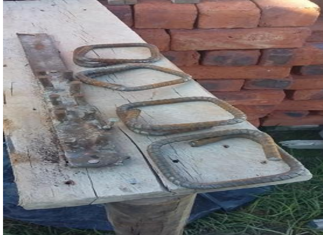
Anexo 13. Doblado de los de los estribos con aceros de 10mm
