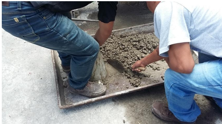
Anexo 5. Realización de mezcla para hormigón de 210
