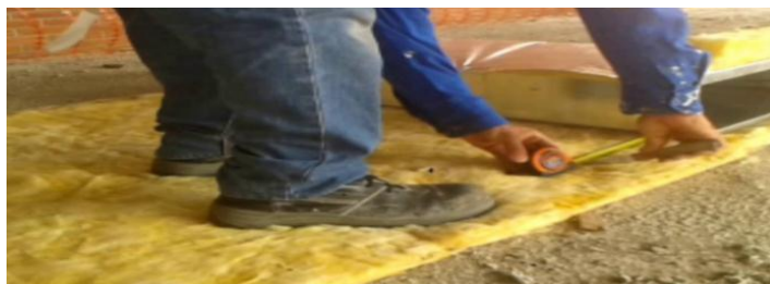
Figura 3.61: Construcción de paredes térmicas.
