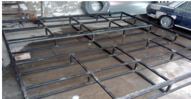
Figura 3.60: Estructura metálica del piso en ensamble.
