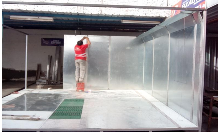
Figura 3.62: Ensamble de paredes y techo.
