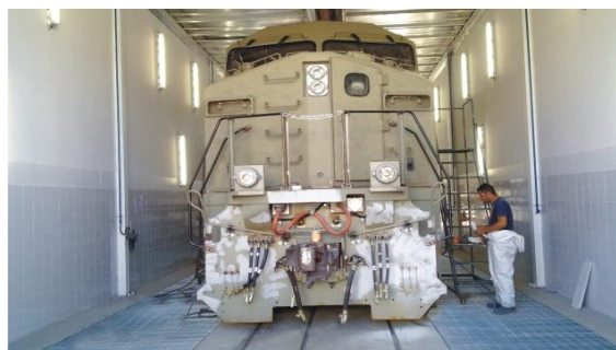
Figura 2. 7: Cabina de pintura para trenes [5].
