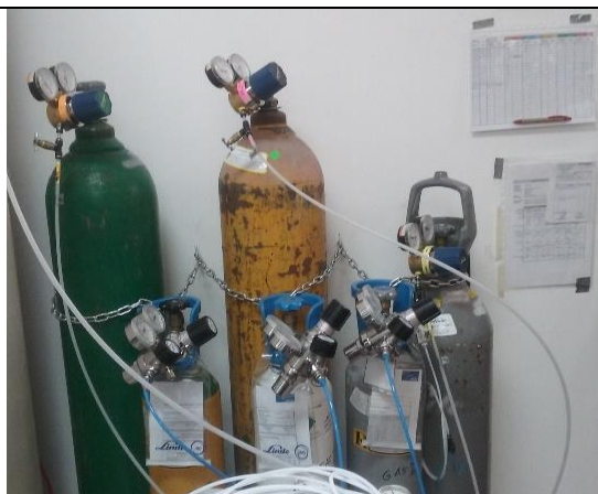
Bombonas de suministro de gas y calibración
