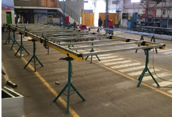
Gráfico 55. Sujeción o prensado de tubería perteneciente a plataforma.
