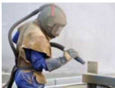
Figura 3-5: Limpieza Chorro Abrasivo Fuente: Autor
