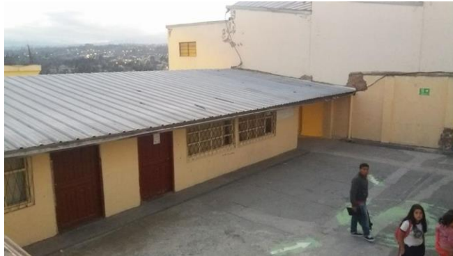
Gráfico 49: Techo de zinc aulas del bloque 2 Fuente: Escuela General Córdova, 2017.
