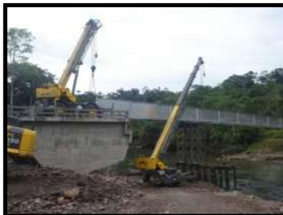
**VIII.** Armado y soldadura FCAW de arriostramiento entre vigas lanzadas -
