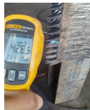
Figura 7. Pre calentamiento de los flancos de los dientes del virador, con un control de temperatura entre 320 y 420°C
