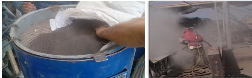
Figura 6. 2. Alimentación de material abrasivo en tolva de equipo sandblasting
