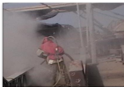
Figura 2. Sandblasting del virador Fuente: Autor
