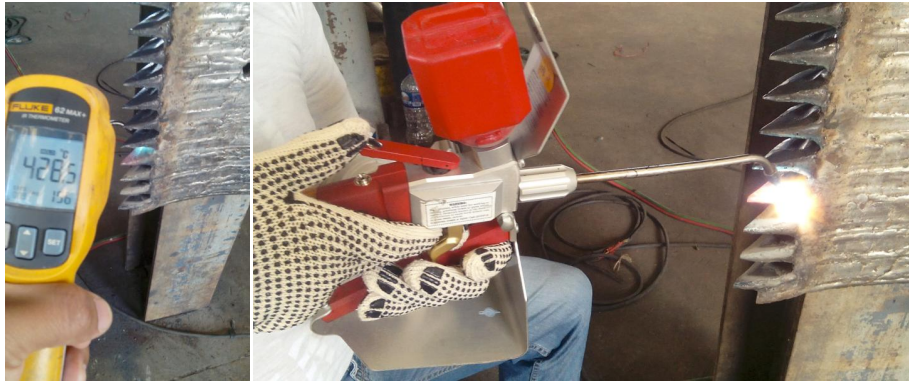
Ilustración 5. Blindaje por proyección térmica de los dientes del virador
