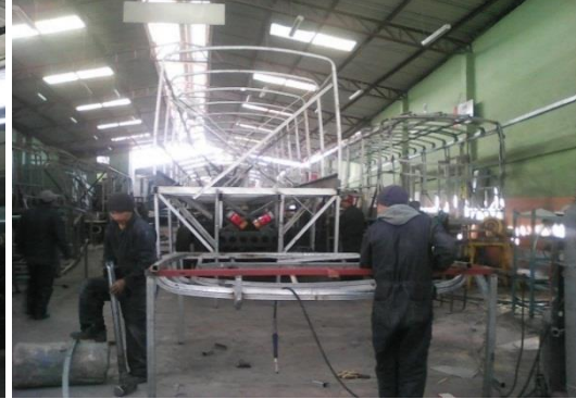
Foto N°.4 Armado de frente y respaldos
