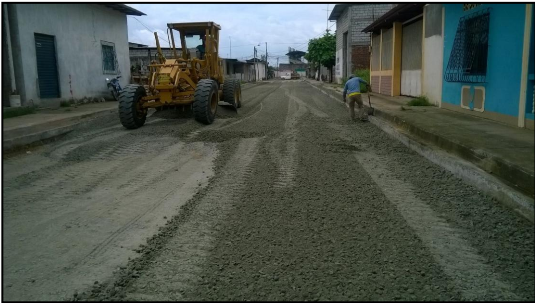
Gráfico N.- 73: Tendido de Sub-base mediante motoniveladora
