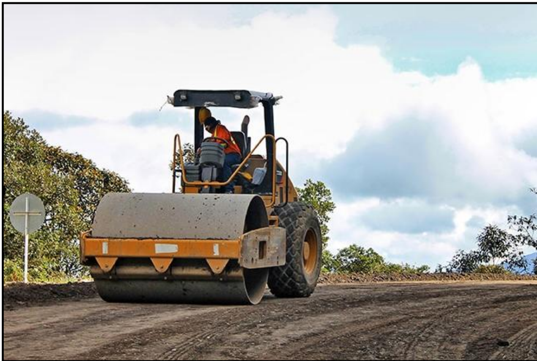
Gráfico N.- 74: Compactación de Base con Rodillo Liso
