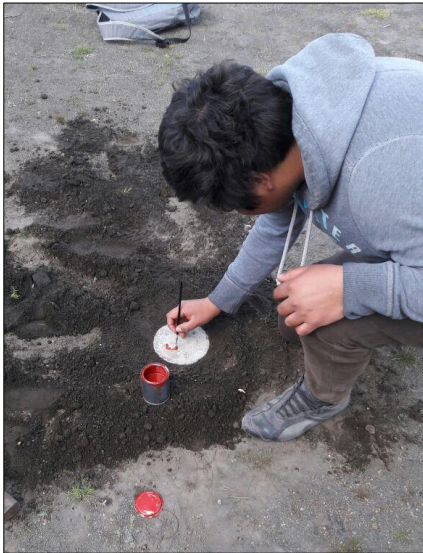
Colocación de B.M.
