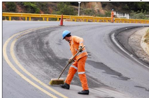
Figura 47: Mantenimiento rutinario. Limpieza del pavimento.
