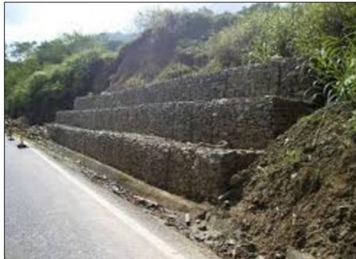
Figura 57: Mantenimiento de emergencia. Protección de terraplenes.
