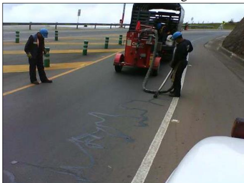
Figura 41: Mantenimiento rutinario. Sello de grietas en el pavimento.
