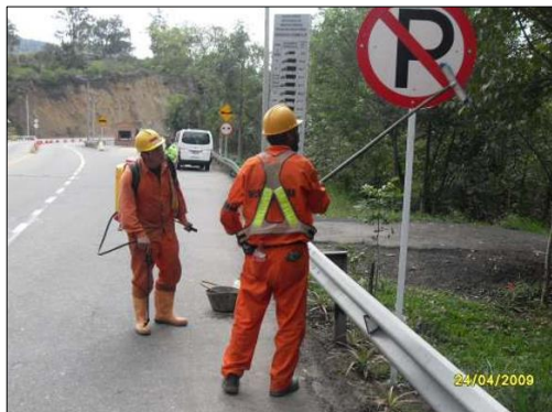
Figura 43: Mantenimiento rutinario. Lavado señales verticales.
