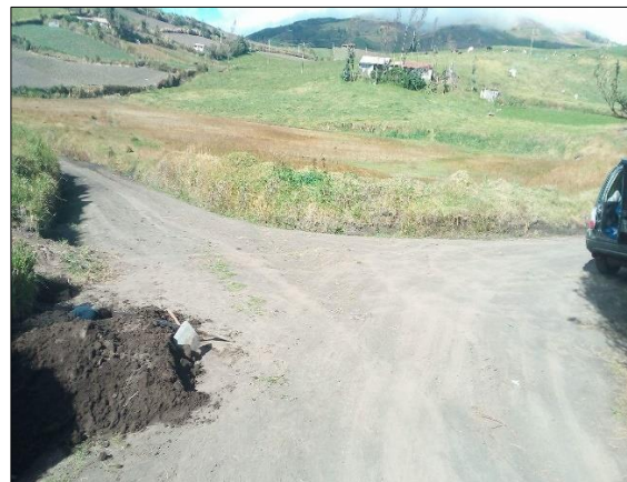
Afloramiento de agua km 2+100.
