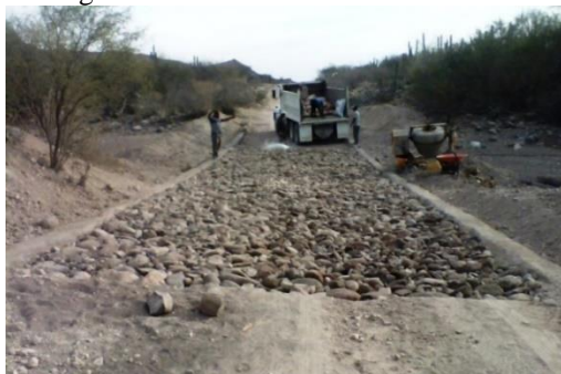
Figura 55:Reconstrucción de carreteras.
