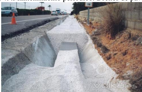
Figura 49: Mantenimiento periódico. Drenes de pavimento.
