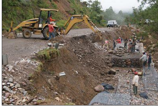
Figura 56: Mantenimiento de emergencia. Relleno de erosiones.
