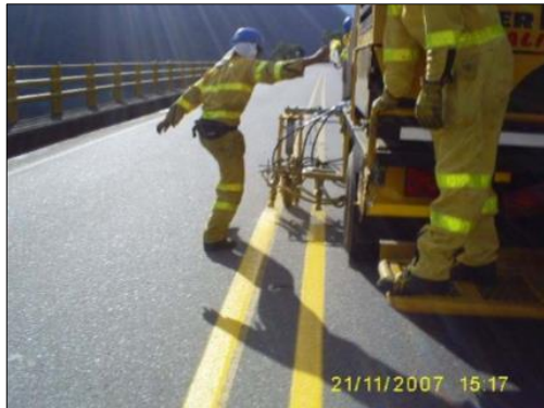
Figura 48: Mantenimiento rutinario. Demarcación del pavimento.
