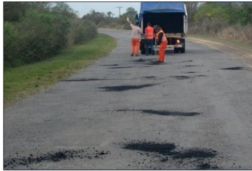
Figura 42: Mantenimiento rutinario. Bacheo superficial.
