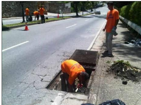
Figura 39: Mantenimiento rutinario. Limpieza de alcantarillas y sifones.
