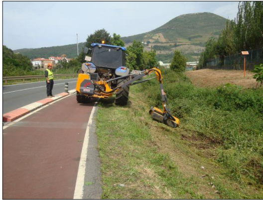
Figura 36: Mantenimiento rutinario. Limpieza de faja.
