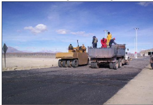
Figura 51: Mantenimiento periódico. Imprimación reforzada
