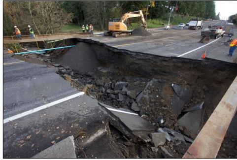
Figura 59: Mantenimiento vial ante sismos
