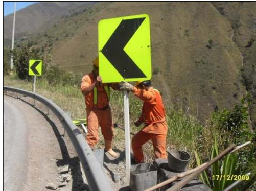
Figura 44: Mantenimiento rutinario. Reacondicionamiento de señales verticales.
