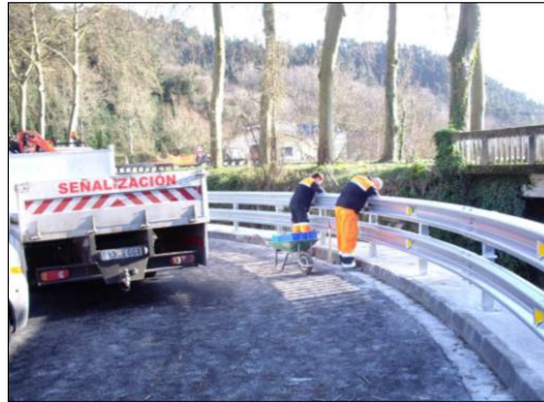
Figura 46: Mantenimiento rutinario. Reparación de barreras metálicas de contención.
