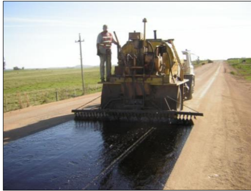
Figura 50: Mantenimiento periódico. Operación de sellos bituminosos.
