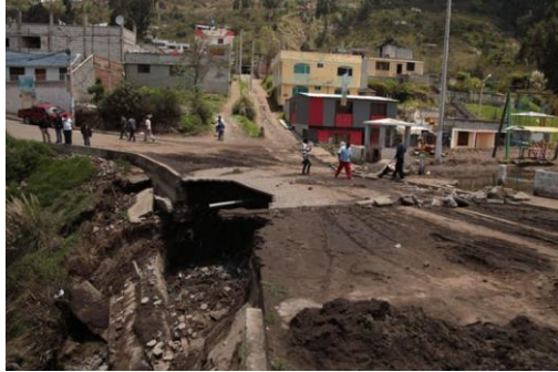
Figura 54:Rehabilitación de carreteras.
