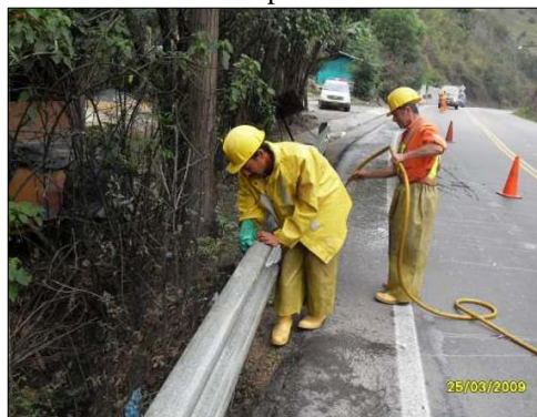
Figura 45: Mantenimiento rutinario. Limpieza de barreras metálicas de contención.
