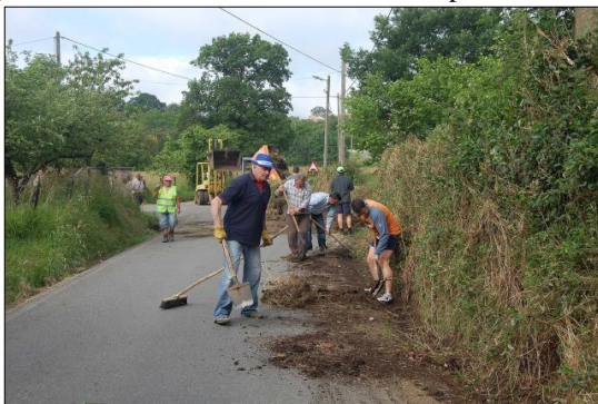
Figura 40: Mantenimiento rutinario. Limpieza de cunetas.
