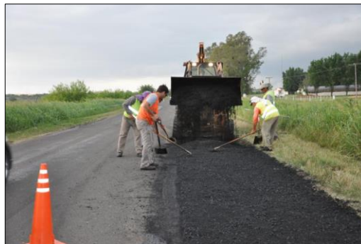
Figura N°46. Mantenimiento rutinario. Bacheo profundo.
