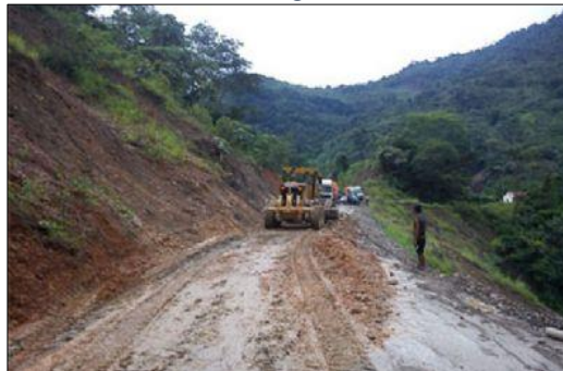
Figura 58: Mantenimiento de emergencia. Extracción de derrumbes.
