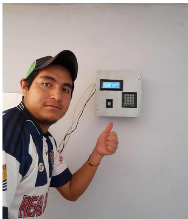
Figura 4.29 Instalación del sistema de recargas
