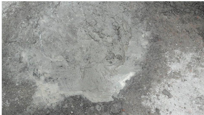
Imagen No.19 Elaboración la mescla de mortero.
