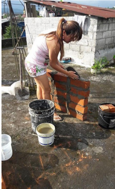
Imagen No.20 Construcción de la pared.
