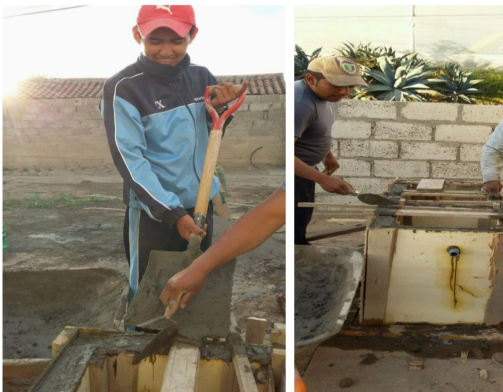
Hormigonado del tanque séptico
