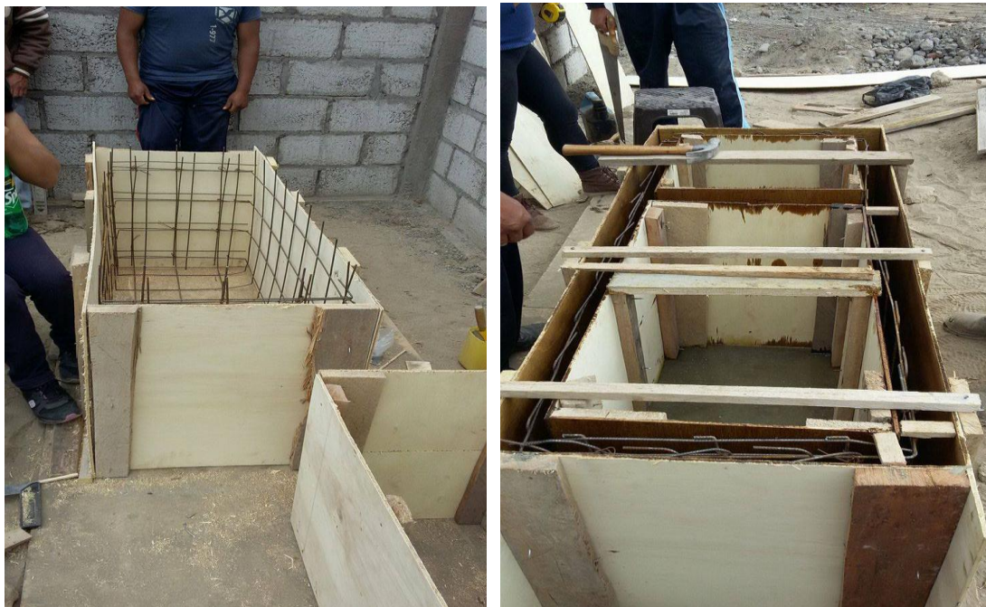
Armado y encofrado del tanque séptico
