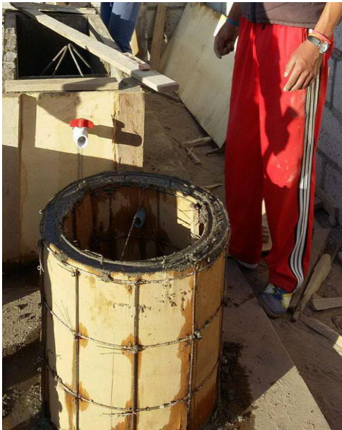
Hormigonado del filtro biológico
