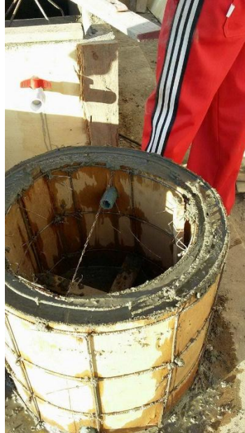
Hormigonado del filtro biológico
