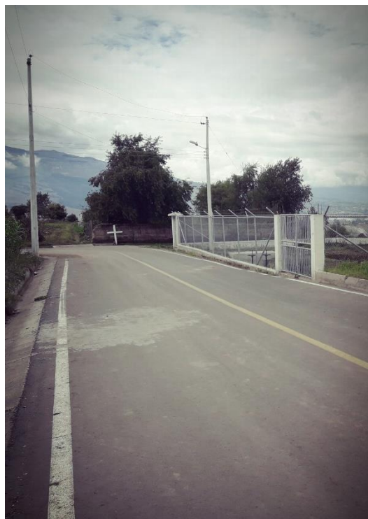
Foto N° 4: Ubicación de la Planta de tratamiento en San Antonio
