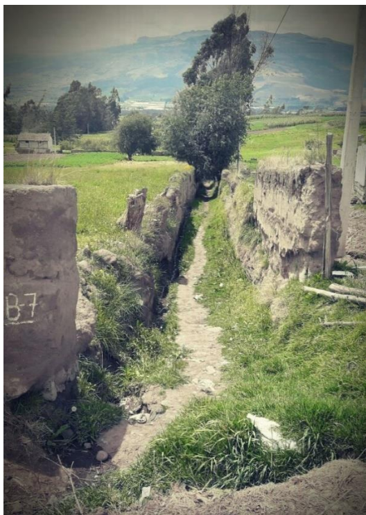
Foto N° 3: Tramo 4 del sector San José La lindera
