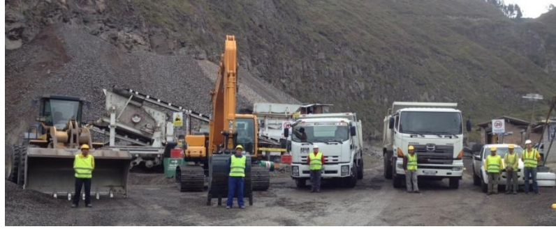
Figura 3 Maquinaria Fuente: Constructora T. Arias Cía. Ltda.
