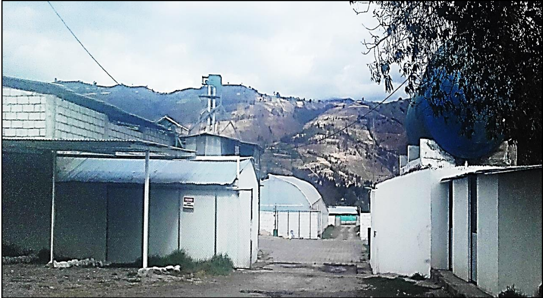
Fig. 1. Fachada Compañía Productora Avícola Cajamarca Suárez "Cavicente" Cía. Ltda.
