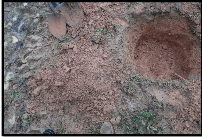
Calicata para la muestra de suelo
