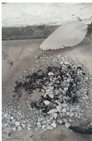
Gráfico N° 27. Mezclado de agregados, asfalto y polímero (P.E)
