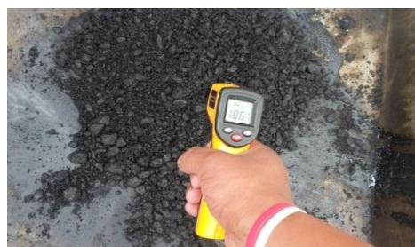
Gráfico N° 14. Mezclado de agregados y asfalto
