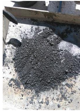
Mezclado del asfalto
