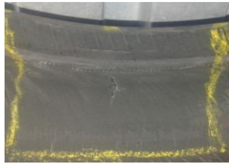
Marcación del área desbastada
