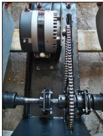
Figura 66 : Montaje al sistema de transmisión
