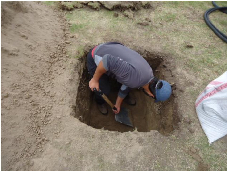
Excavación de suelo calicata 1
