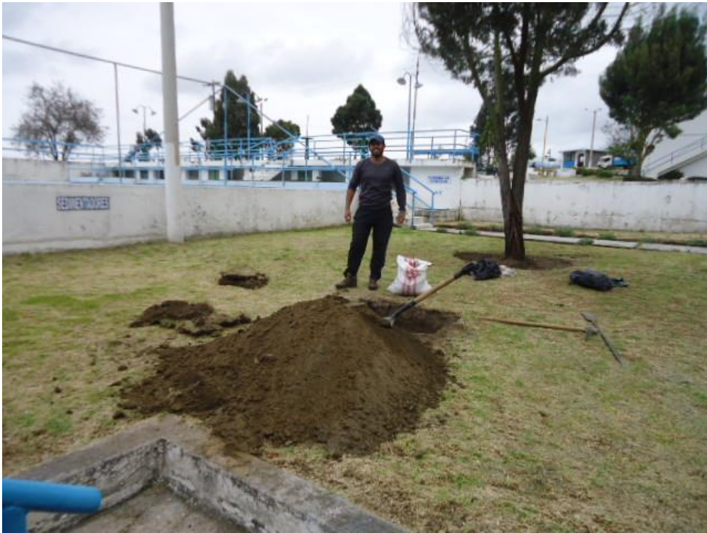
Muestra de suelo calicata 2
