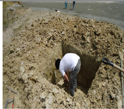
Excavación a 1m de la Calicata
