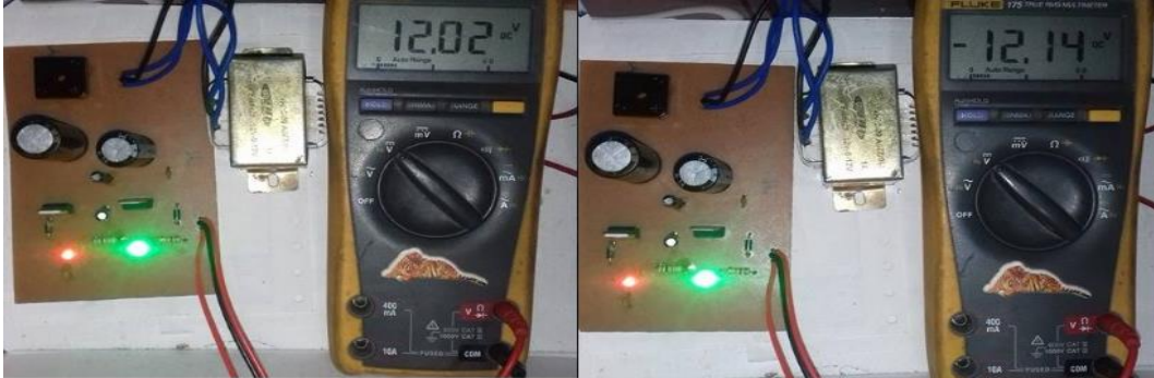
Fig. 4. 47 Prueba de funcionamiento etapa de alimentación.
