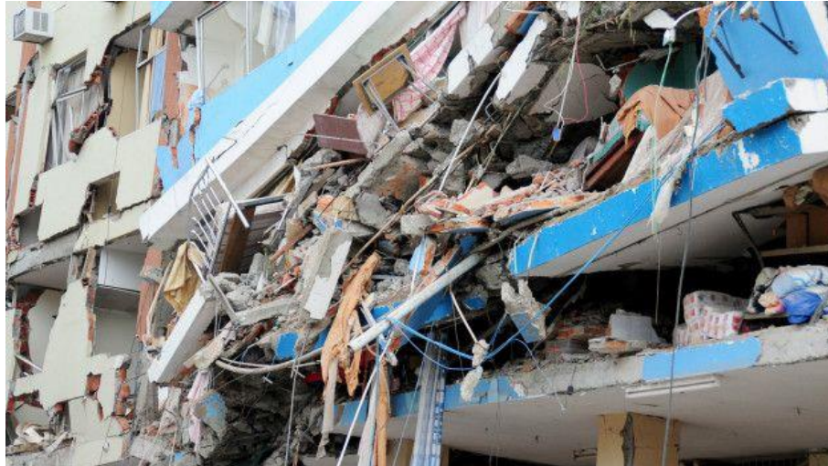
Fotografía N° 4: Edificio colapsado, terremoto 2016 Fuente: BBC Mundo (2016)
