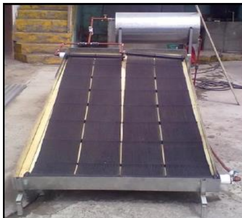
Figura 2-9; Colector solar plano de tubos de polipropileno; Fuente: [9]
