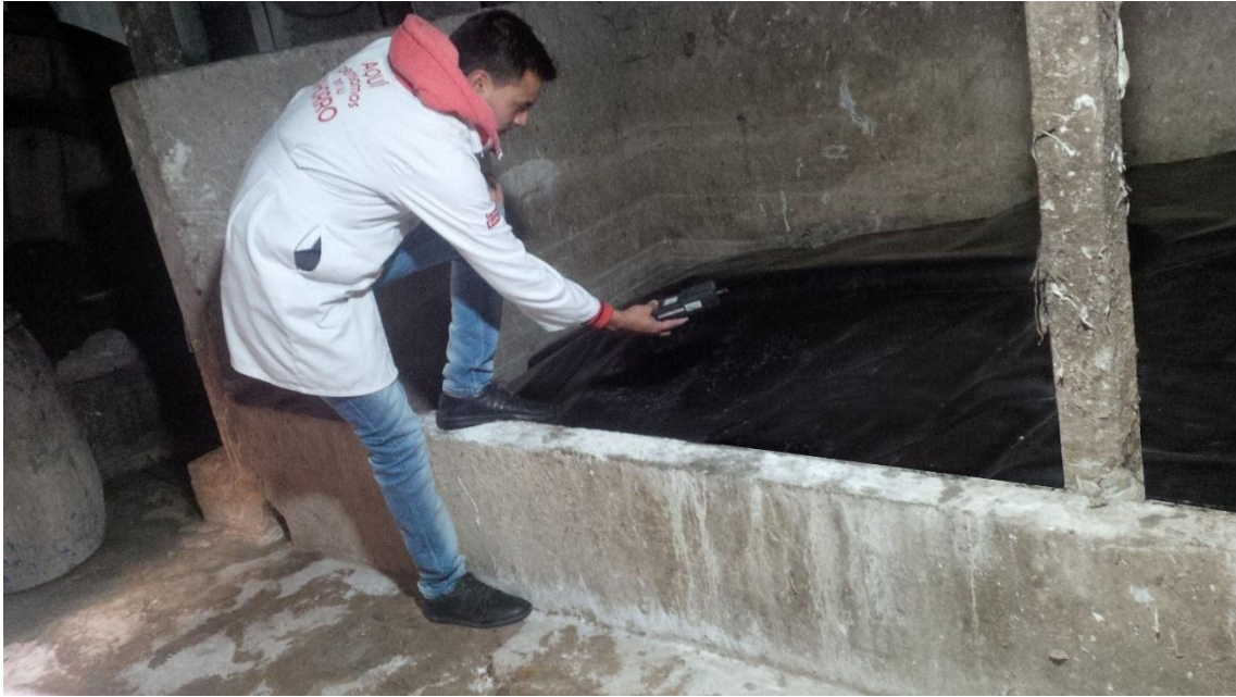
Fotografía 7 Geomembrana HDPE instalada.
