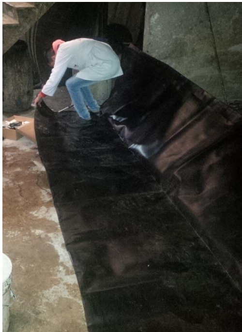
Fotografía 6 Desplegando la Geomembrana HDPE.
