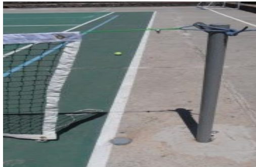
Ilustración 10: Postes de la cancha de tenis
