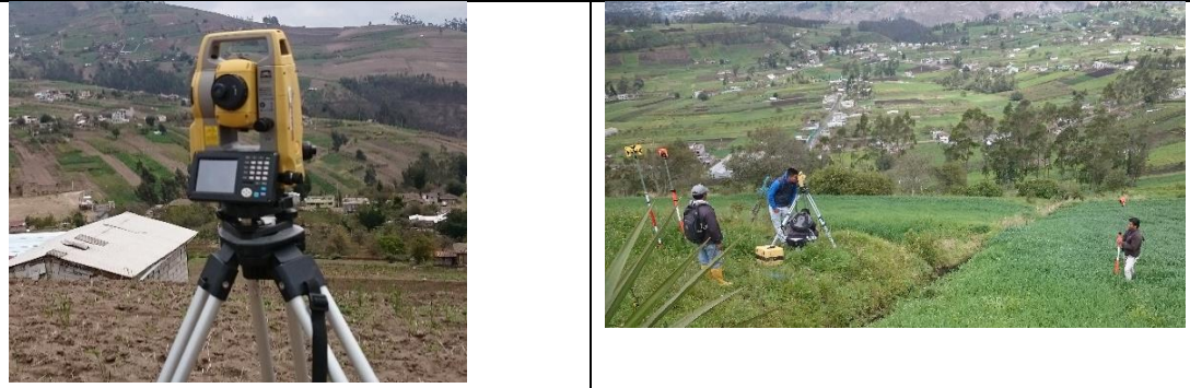
Plantada, nivelación y orientación geográfica de la estación total TOPCON OS 105
