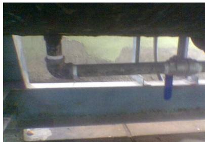
Fig 20: Válvula de purga de fondo
