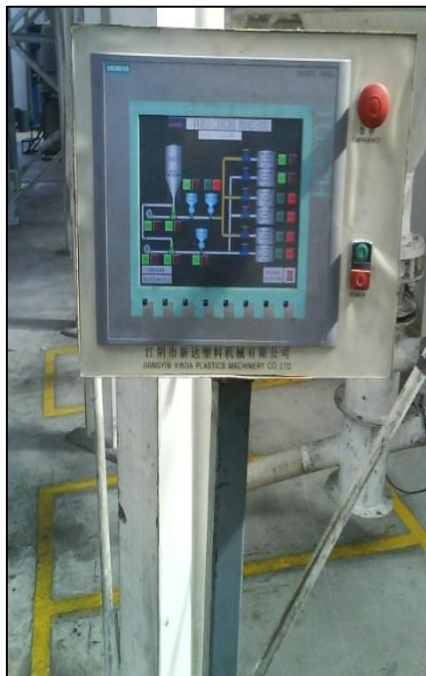
Figura 6. 91 Instalación de la pantalla táctil Elaborado por: El Investigador
