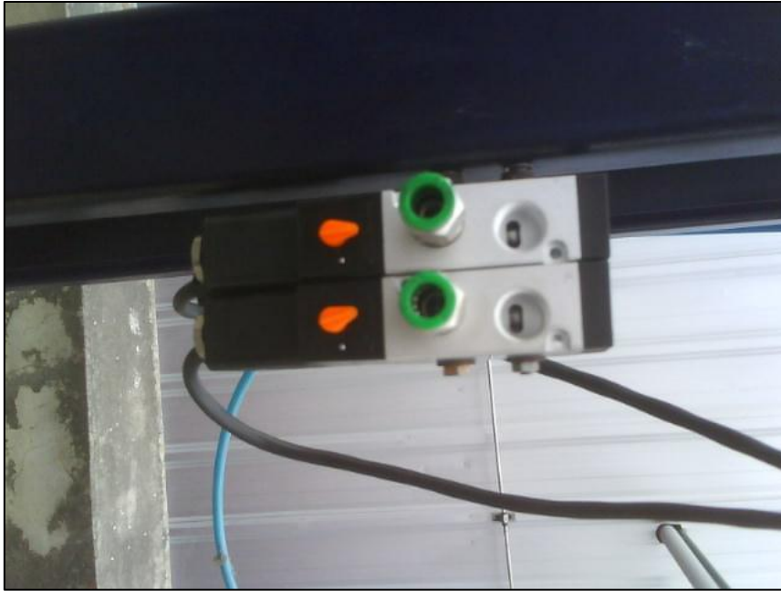
Figura 6. 87 Fijación de las electroválvulas Elaborado por: El Investigador
