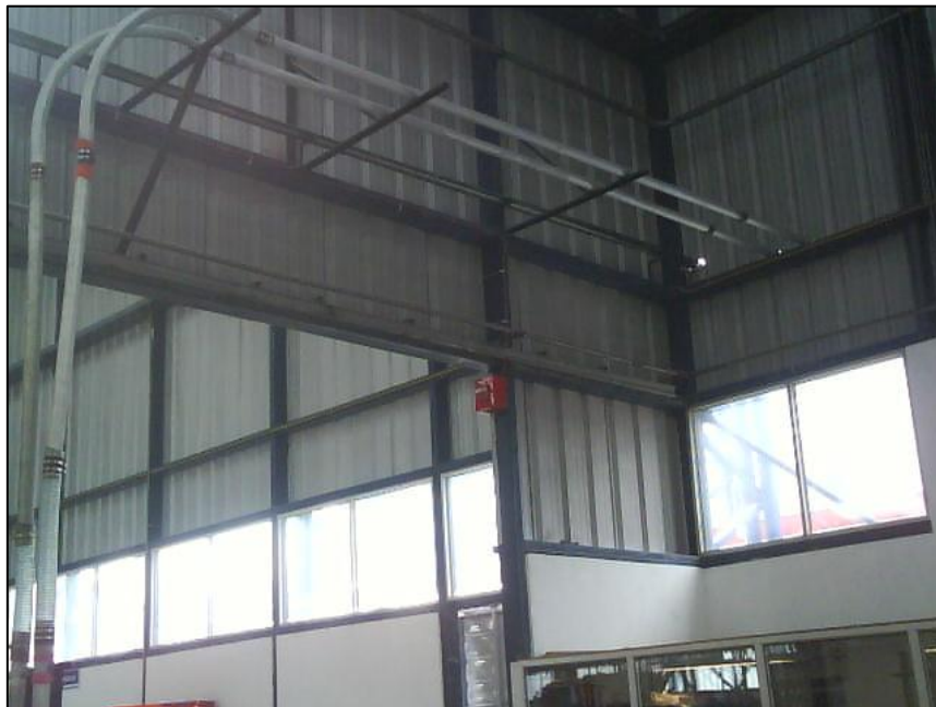
Figura 6. 84 Instalación de tuberías en la Sección Prefabricados Termoplásticos Elaborado por: El Investigador
