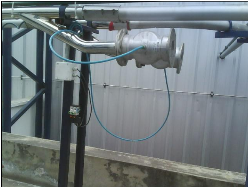
Figura 6. 86 Acople de las válvulas pinch Elaborado por: El Investigador
