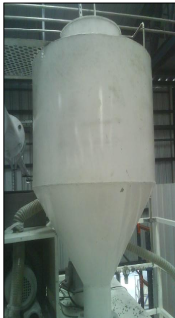
Figura 6. 88 Instalación de tolvas que reciben el PVC en la Sección Calzado Lona Elaborado por: El Investigador
