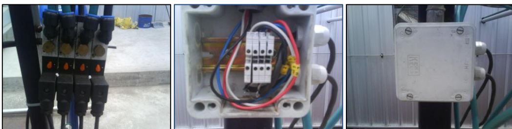
Figura 6. 94 Conexión de las electroválvulas
