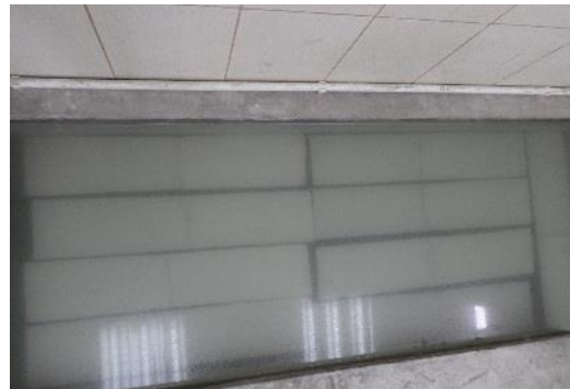
Fotografía 34.- Sistema de Curada para las Vigas
