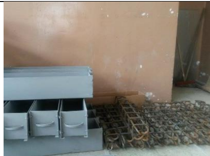
Fotografía 28.- Encofrados Metálicos y Armaduras
