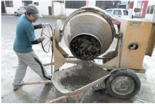
Fotografía 29.- Mezcla en la Concretera
