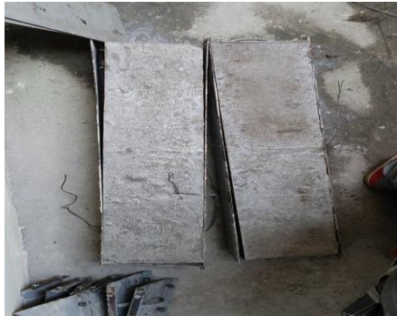
GRÁFICO 45.-Desencofrado para Vigas con Acero, Bambú y Caña Guadúa
