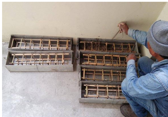
GRÁFICO 33 Encofrado de Vigas con Acero, Bambú y Caña Guadúa
