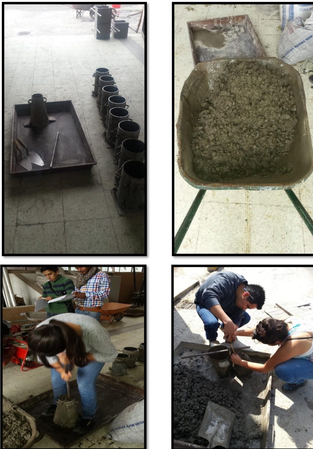
Fotografía 10. Determinación del asentamiento de la mezcla. Fuente: Egda. Johana Núñez
